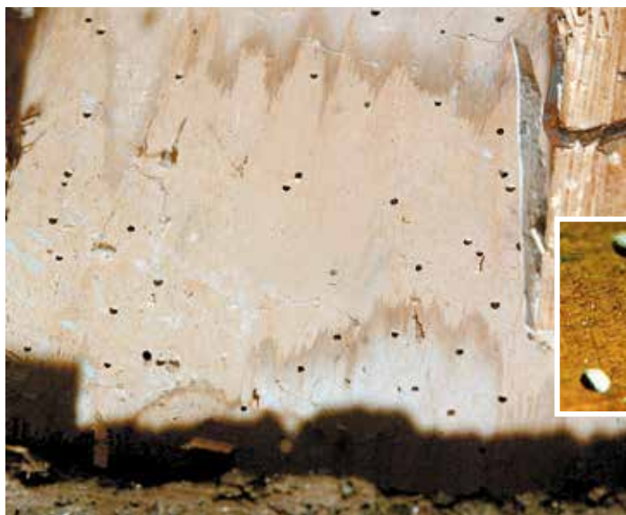
Tupajumin lentoreikiä rakenteessa.
