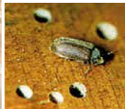
Tupajumin lentoreikiä rakenteessa.
