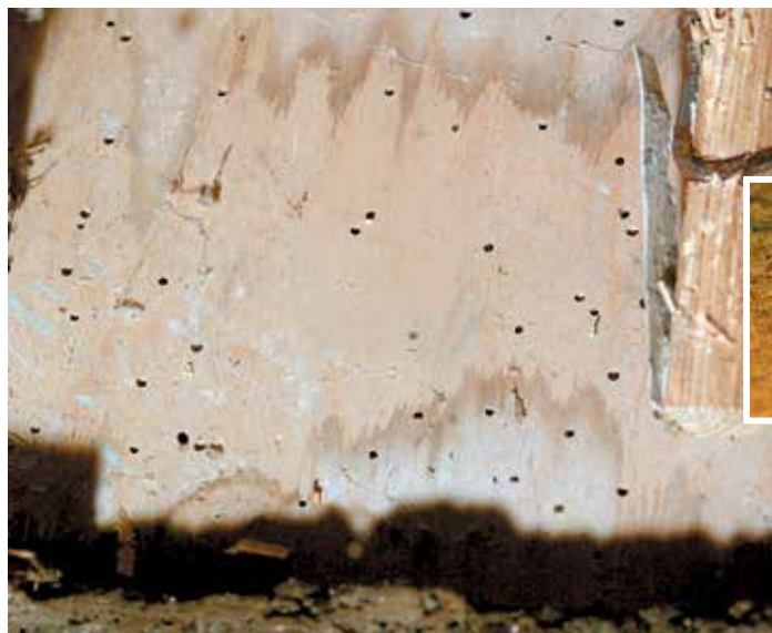
Tupajumin lentoreikiä rakenteessa.
