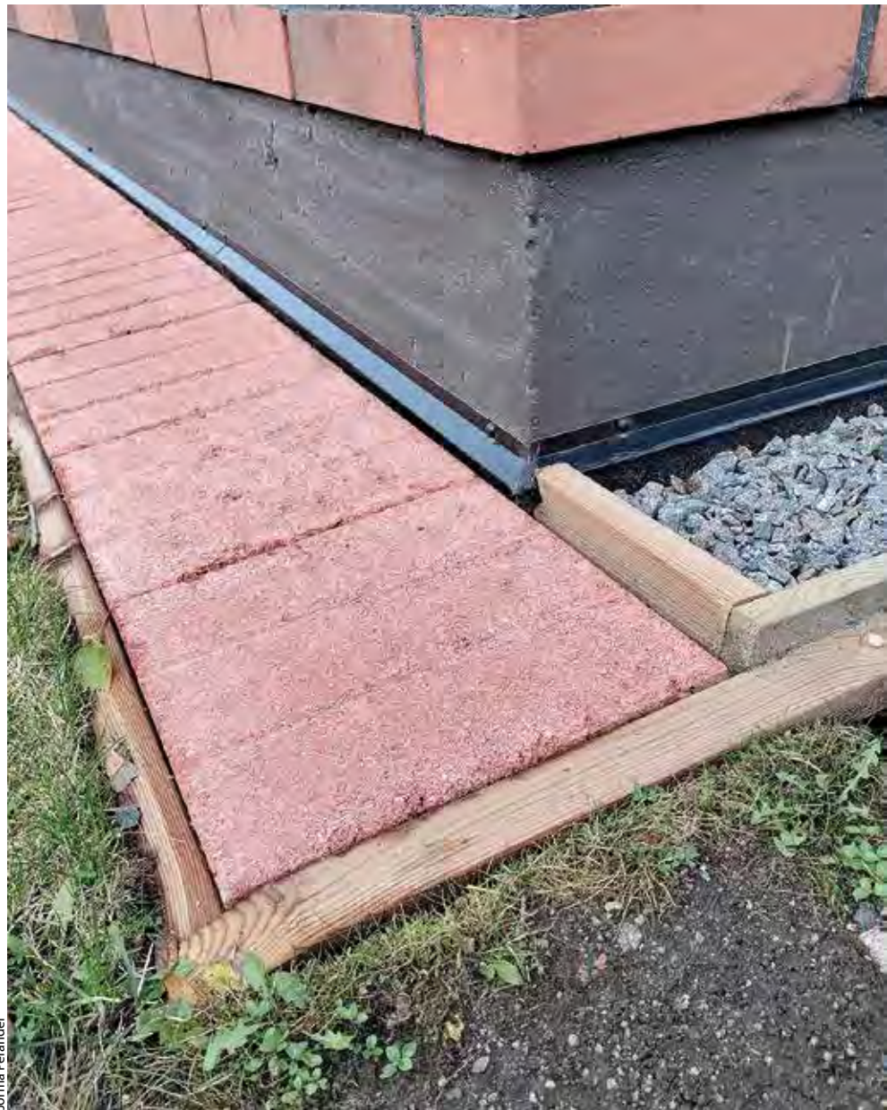
Työmaan ollessa valmis, patolevyn reunalista jää näkyviin maanpinnan yläpuolelle.
