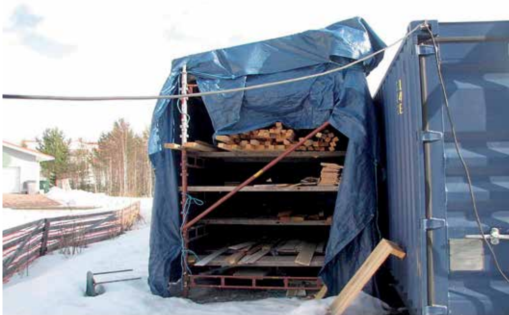
Huolimaton varastointi voi pilata hyvän rakentamisen.
