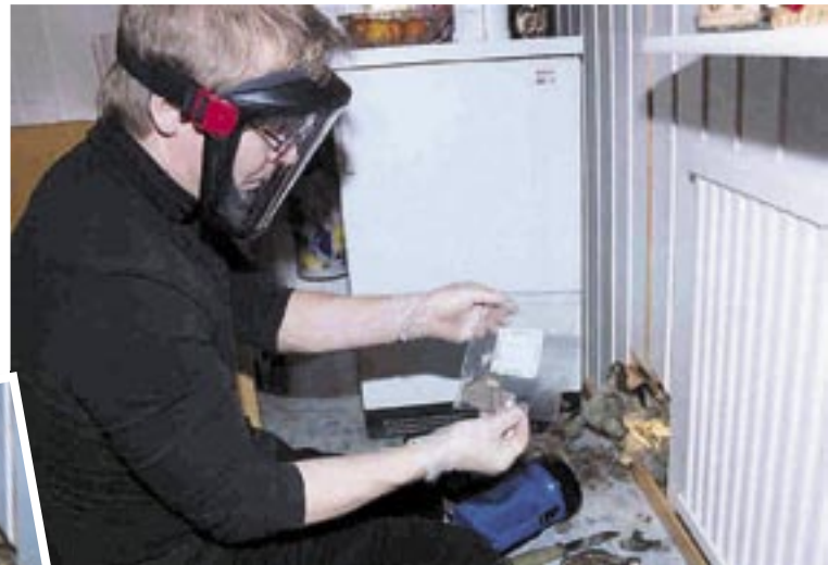
Arviolta kolmannes mikrobivaurioista jää piiloon rakenteiden sisälle. Niiden löytämiseksi on tehtävä kosteusmittauksia porausrei'istä, avattava rakenteita ja otettava mikrobinäytteitä. Juhani Pirinen näytepussissa on lämmöneristevillaa.
